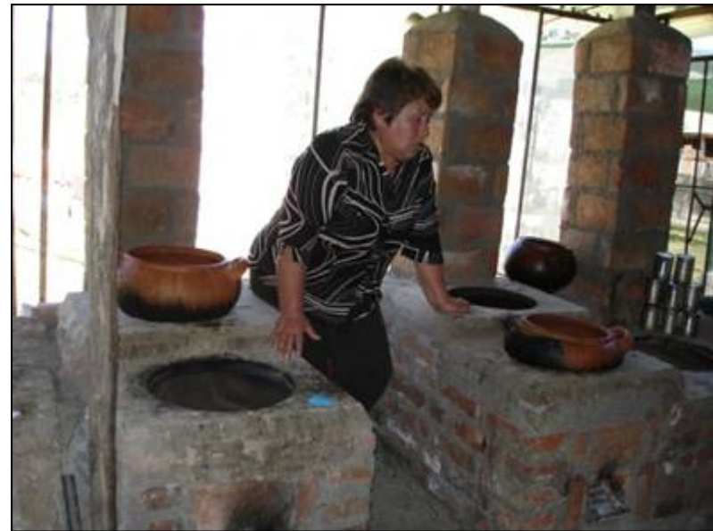
Cocinas mejoradas instaladas en restaurantes - Characato
