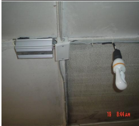
Izquierda superior, vista de un foco tipo LEDs de 5 W, 12 VDC; inferior, una lámpara tipo de inducción magnética (LVD) 15 W / 12 VDC; derecha, pararrayo y panel fotovoltaico instalado en un Centro Educativo
