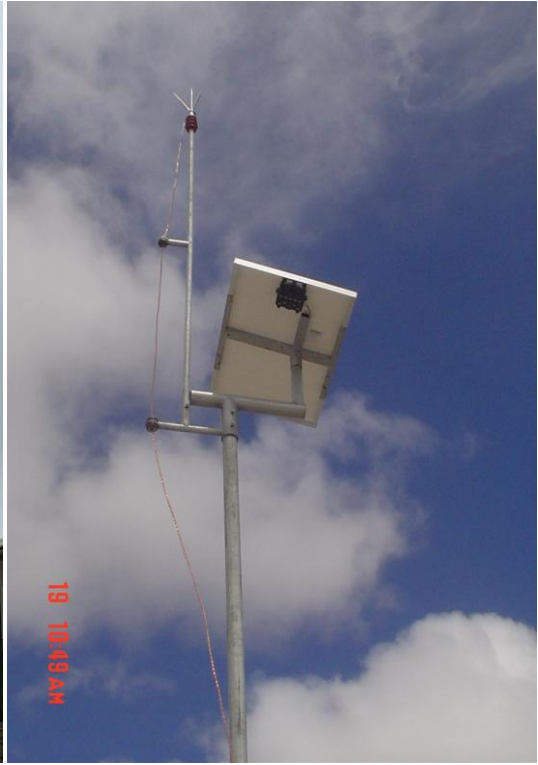
Vista general de los sistemas pararrayos tetrapuntal tipo Franklin, instalados en los sistemas fotovoltaicos de carga especial en Centros Educativos y Puestos Policiales de la zona alto andina de la región Tacna
