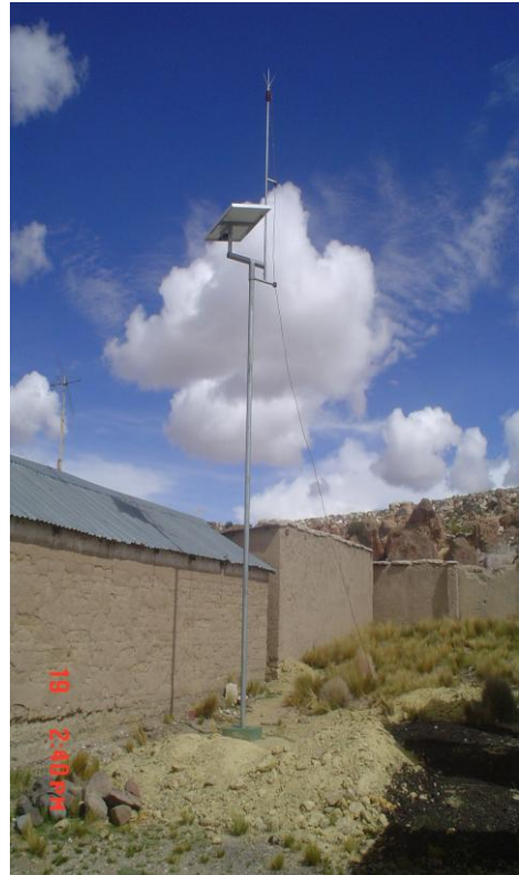
Izquierda superior, vista de un foco tipo LEDs de 5 W, 12 VDC; inferior, una lámpara tipo de inducción magnética (LVD) 15 W / 12 VDC; derecha, pararrayo y panel fotovoltaico instalado en un Centro Educativo
