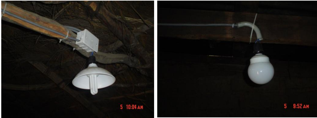
Izquierda, vista de la instalación de lámparas de iluminación tipo CFL con pantalla difusora, 11 W / 12 VDC; derecha, tipo LEDs de 5 W, 12 VDC
