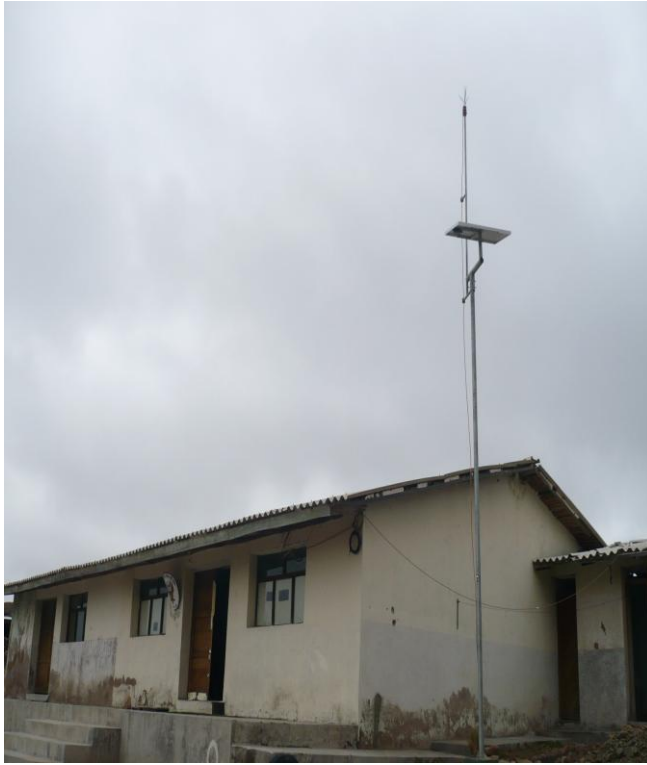
Vista general de los sistemas pararrayos tetrapuntal tipo Franklin, instalados en los sistemas fotovoltaicos de carga especial en Centros Educativos y Puestos Policiales de la zona alto andina de la región Tacna
