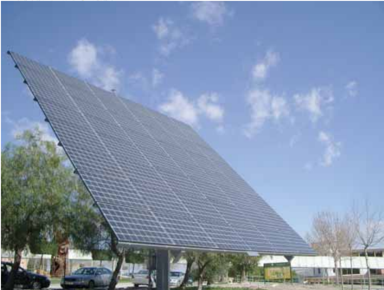
Seguidor solar de 10 kW instalado en la Universidad de Jaén
