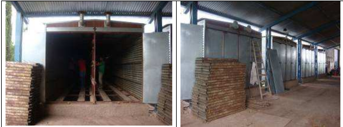
Figura 1- Vista de frente de la estufa bajo estudio, y perspectiva de parque de estufado del establecimiento.
