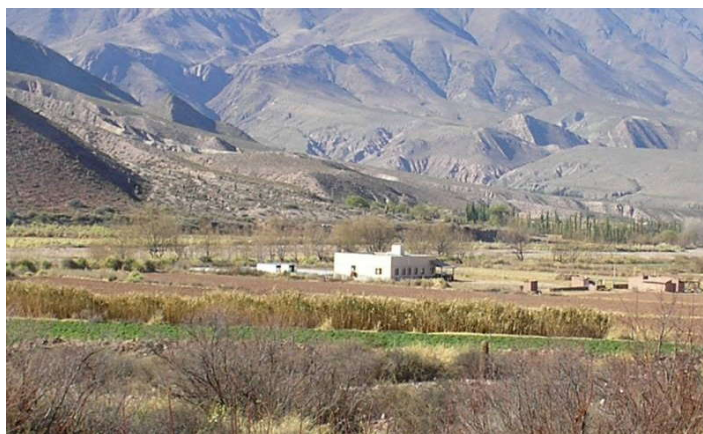
Fig. 1: Planta de deshidratado de Huacalera, Quebrada de Humahuaca.
