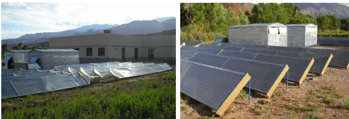
Figuras 7 y 8: Secador solar de Huacalera, Quebrada de Humahuaca. Vista de colectores, cámara de secado y caño maestro del secador.
