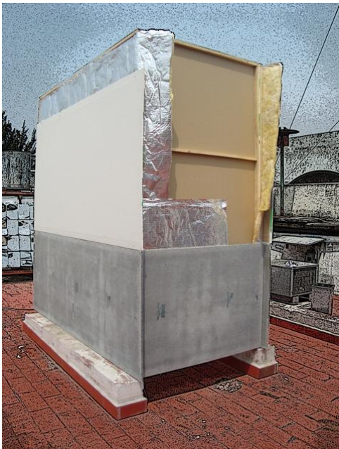
Figura 4- Imagen que muestra el proceso constructivo del módulo, en él se pueden observar los materiales con los que está construido.
