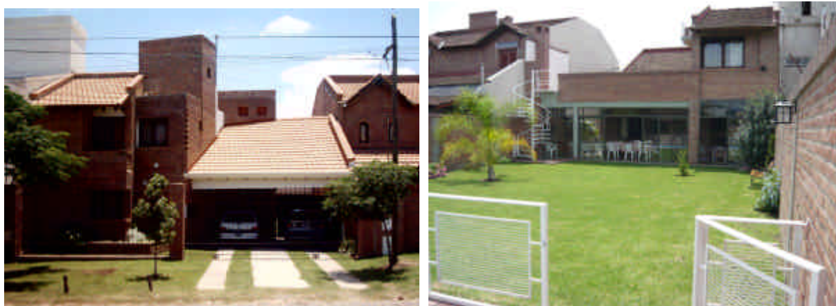
Figura 2 - Fachada y contrafachada de la vivienda.
