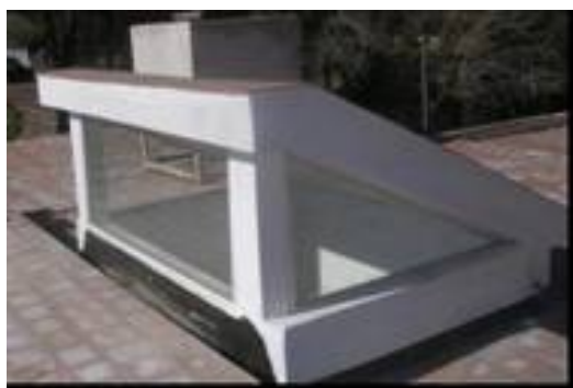
Figura 10. Foto de lucernario construido.
