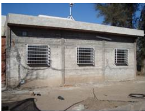
Figura 7. Ubicación en ventanas fachada norte.
