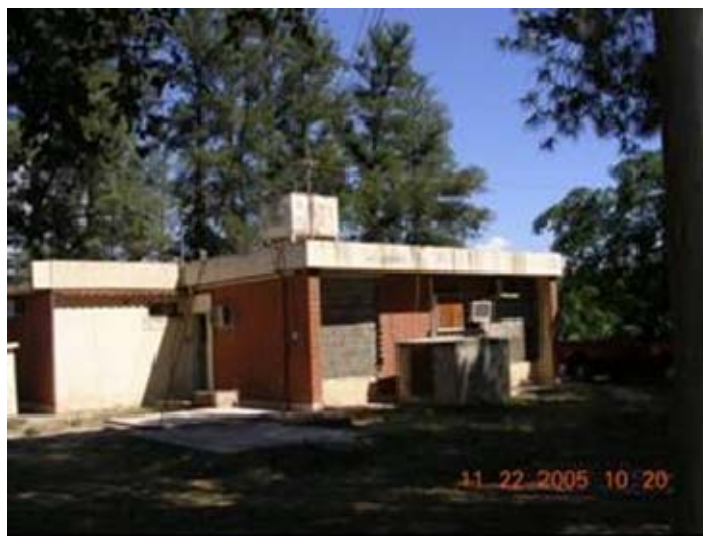
Figura 1.- Vista exterior del edificio utilizado como laboratorio de propagación agámica
