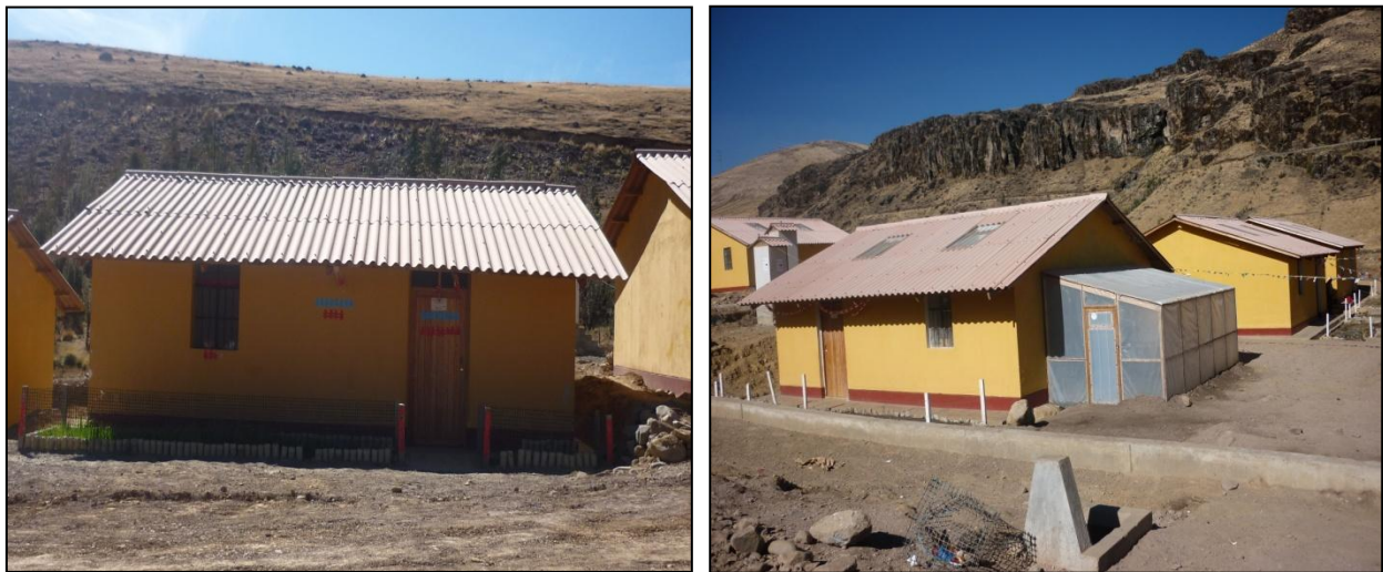
Figura 1. Izquierda: Vista exterior de la vivienda Tipo1. Derecha: Vista exterior de la vivienda Tipo 3.
