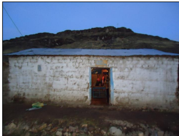
Figura 2. Vista exterior de la vivienda típica.
