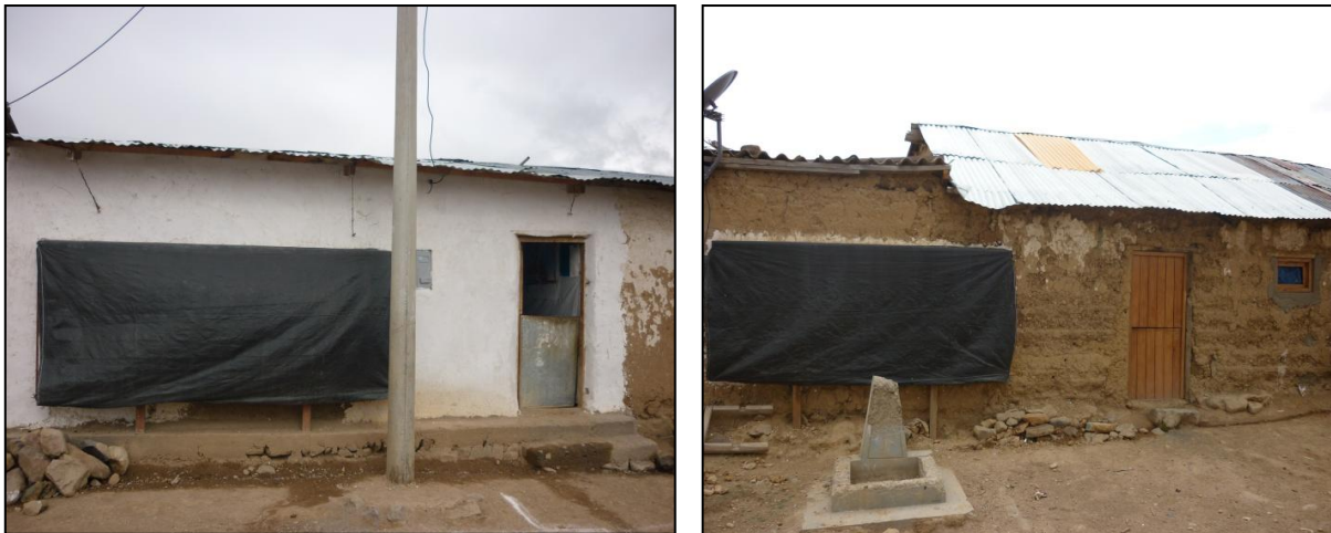
Figura 3. Izquierda: Vista exterior de la vivienda Tipo 4. Derecha: Vista exterior de la vivienda Tipo 5.
