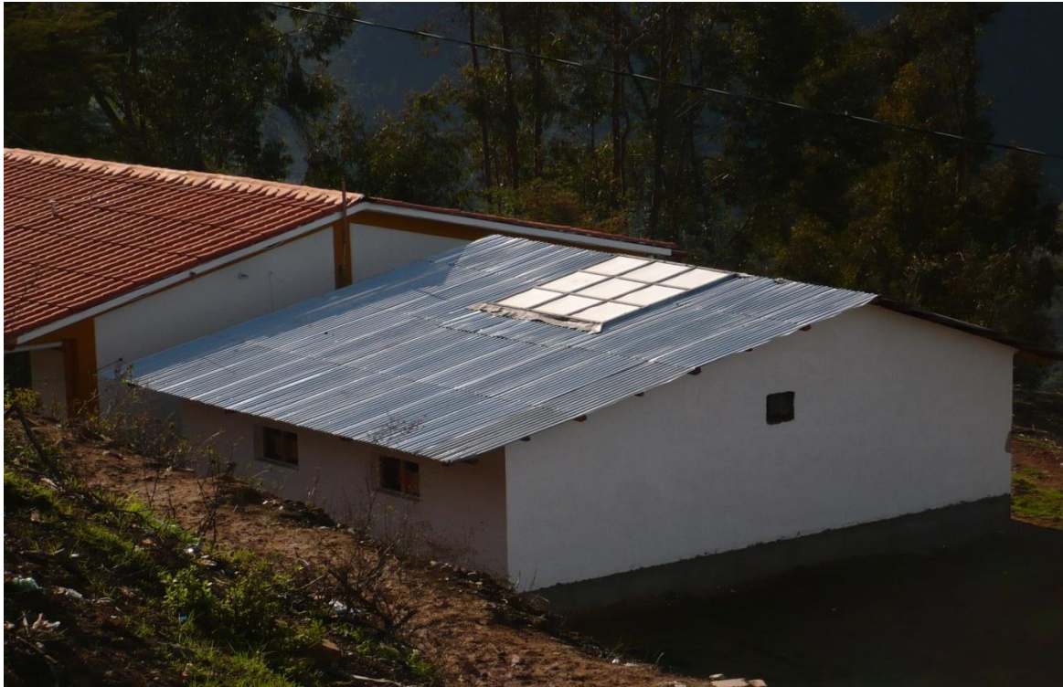
Maternidad solar. Huanchay – Huaraz, Ancash.
