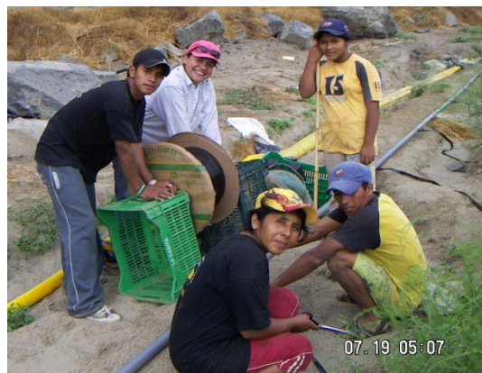
Fig. 3: Instalación de las cintas de goteo.
