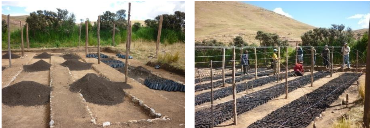
Figura 5. Construcción de 3 invernaderos tipo túnel para los almácigos.
