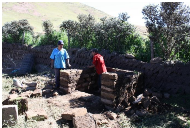
Figura 3. Construcción de la compostera.
