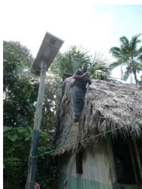
a) Inspección módulo FV
