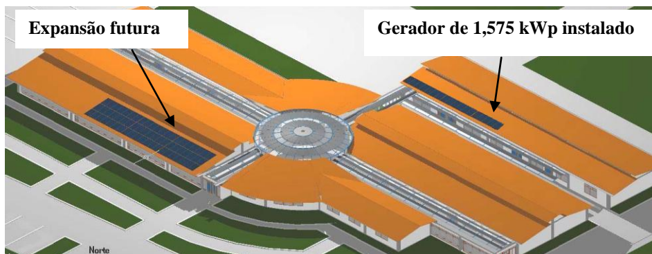
Figura 1 – Incorporação dos módulos fotovoltaicos na edificação
