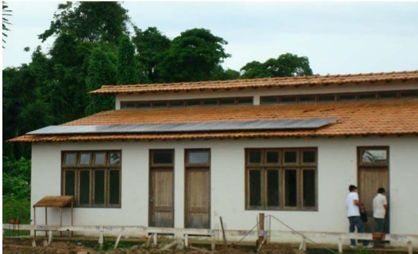
Figura 2 - Vista do 1º SFCR da região amazônica, integrado à edificação do GEDAE.
